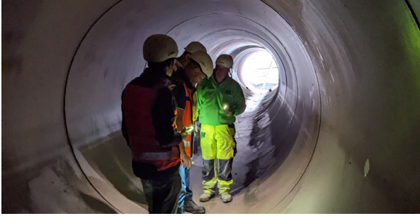
Seit Anfang März sind die Tiefbauarbeiten in Reindl und Untermaxkron wieder in vollem Gange (siehe Titelbild).
