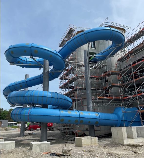
Die Rutsche ist schon aufgebaut - Das PiORAMA nimmt Gestalt an.
