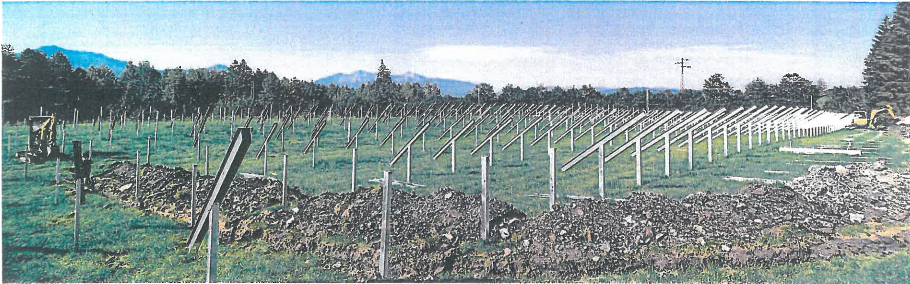
Solarpark auf der grünen Wiese: Kurz nach der Edenhofer Brücke sind die ersten Gestelle für die PV-Module aufgestellt.
